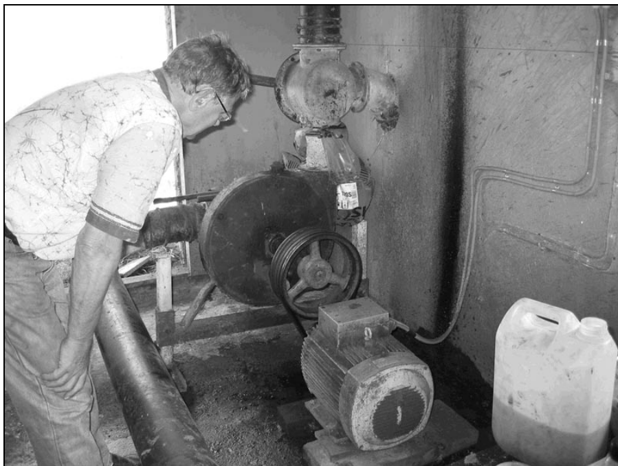
Figur 9. Nils inspekterar omrörningspumpen sommaren 2003.
