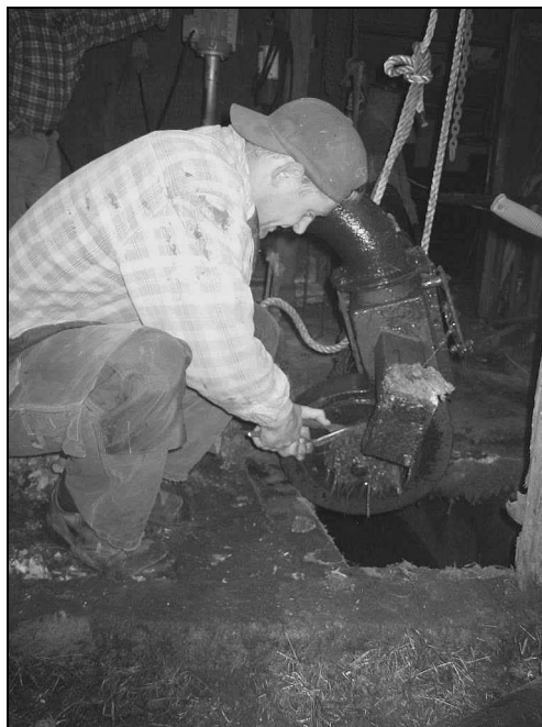
Figur 10. Erik reparerar gödselpumpen i pumprummet intill ladugården.
